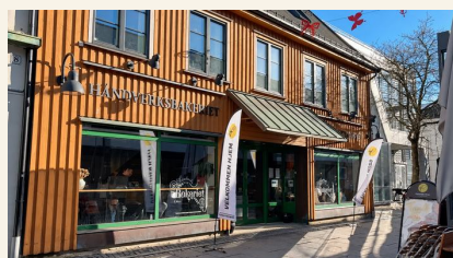
Inngangen fra gågata Dronningens gate 10
